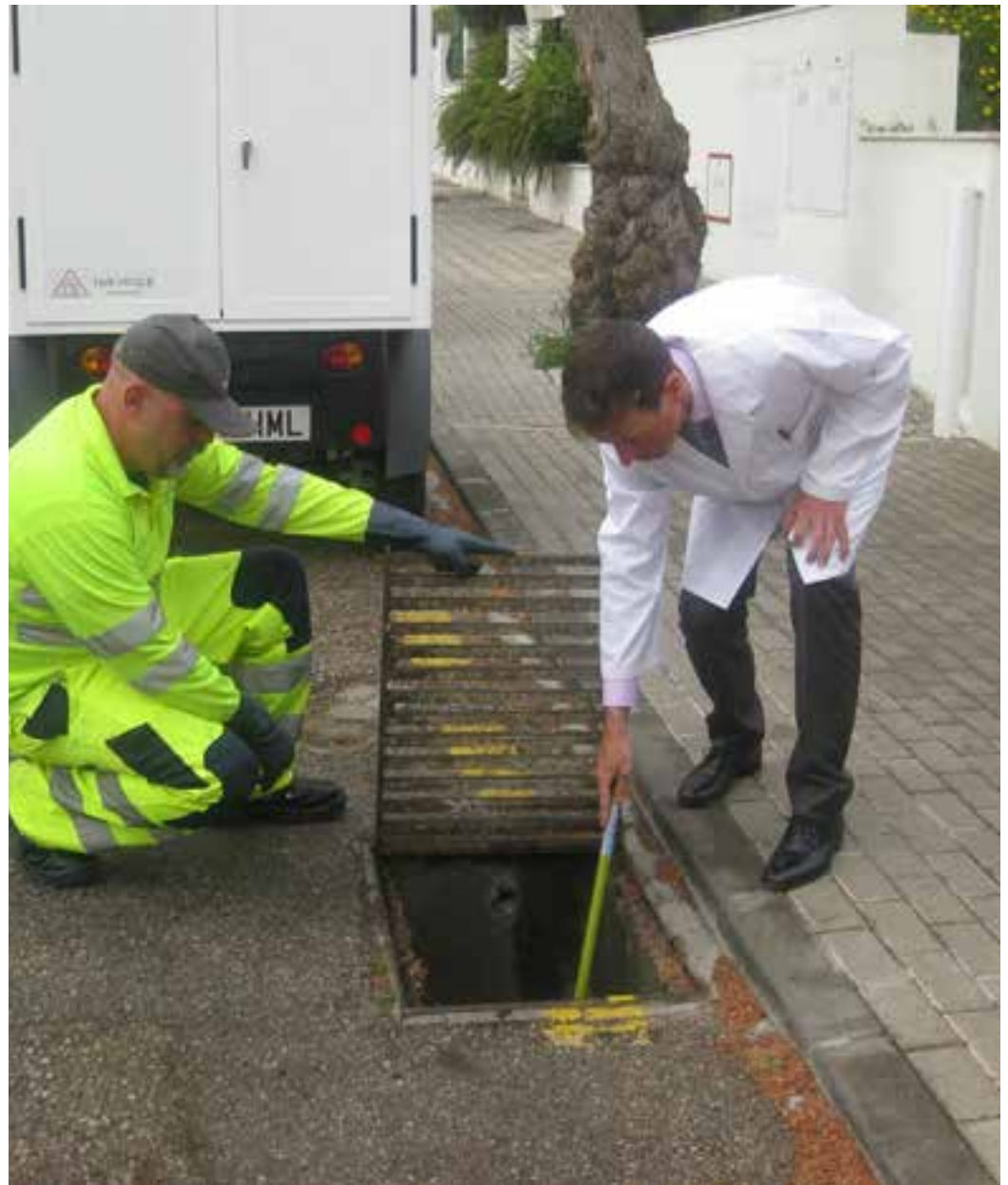
Figura 5. Tratamiento de larvas del mosquito tigre en imbornal (cubeta con rejilla para el desagüe de aguas pluviales) mediante la aplicación de una silicona natural biodegradable que rompe la tensión superficial del agua.
